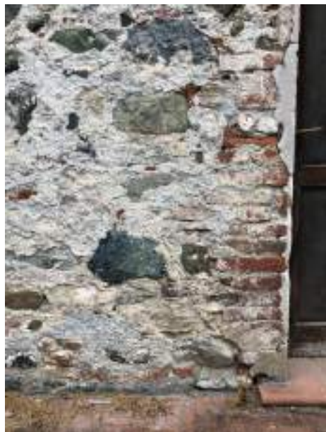
FOTO 1. Muratura eterogenea costituita di pietre di fiume sbozzate, ciottoli e mattoni pieni di diverse colorazioni e dimensioni
