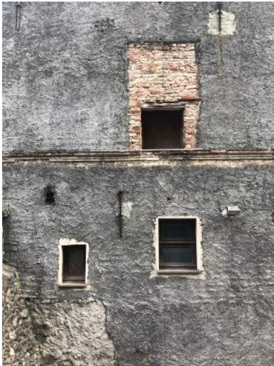
FOTO 4. Intonaco cementizio armato che ricopre il fronte ovest
