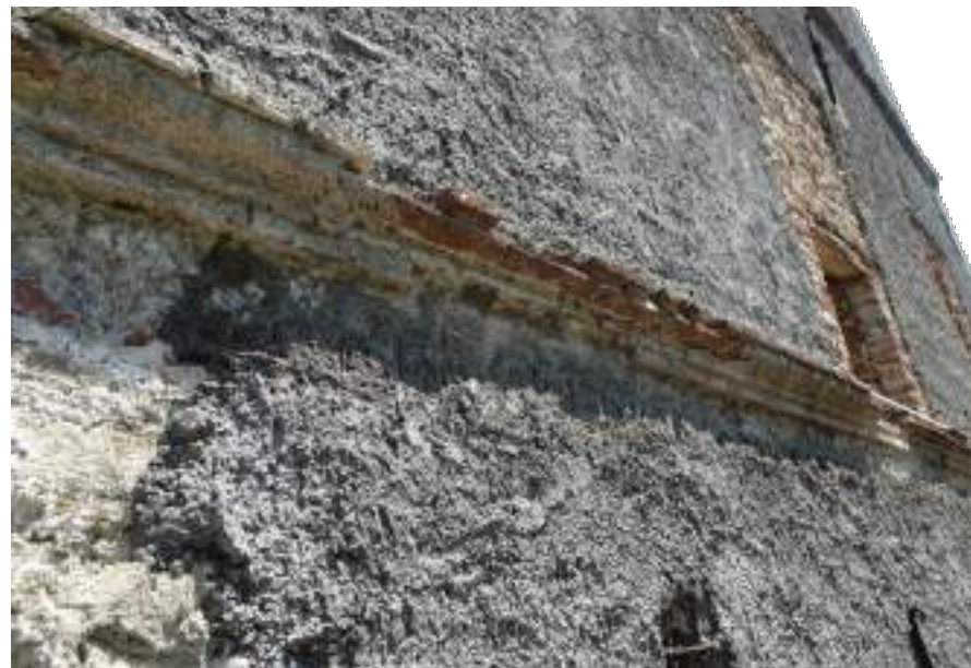
FOTO 2. Dettaglio della cornice marcapiano in parte fortemente degradata e in parte mancante
